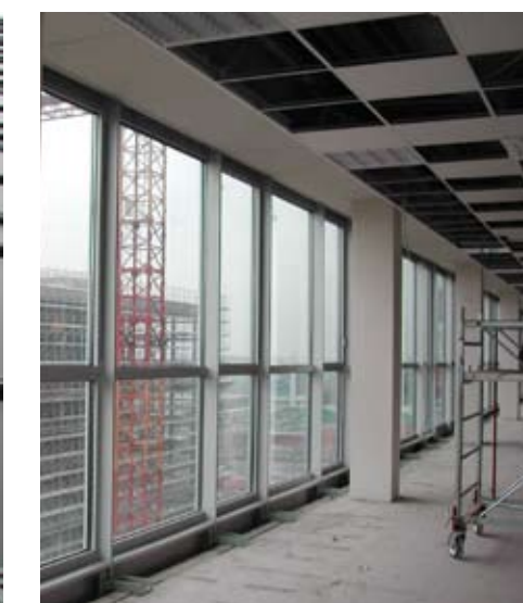
Le facciate dall'interno.
